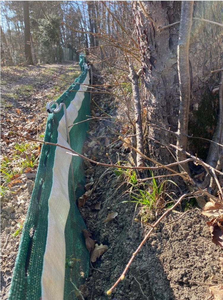
Abbildung 2: Temporäre Amphibienschutzanlage in Wien 14/17, Neuwaldegger Straße & Amundsenstraße
