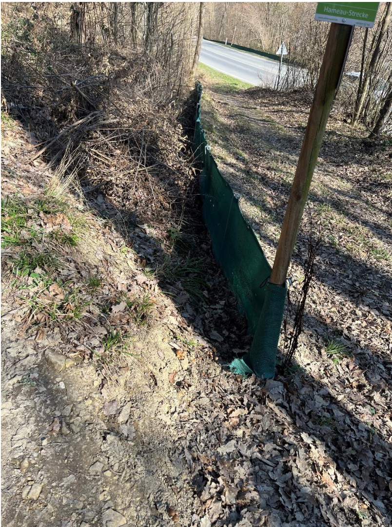
Abbildung 3: Fehlendes Umkehrelement, fehlender Überstiegsschutz und fehlender Kübel
