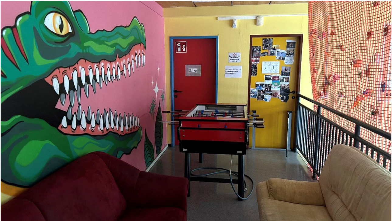
Abbildung 3: Hindernisse im Fluchtweg der beiden Büros
