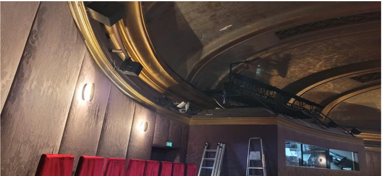
Abbildung 5: Modernisierung des Zuschauerhauses
