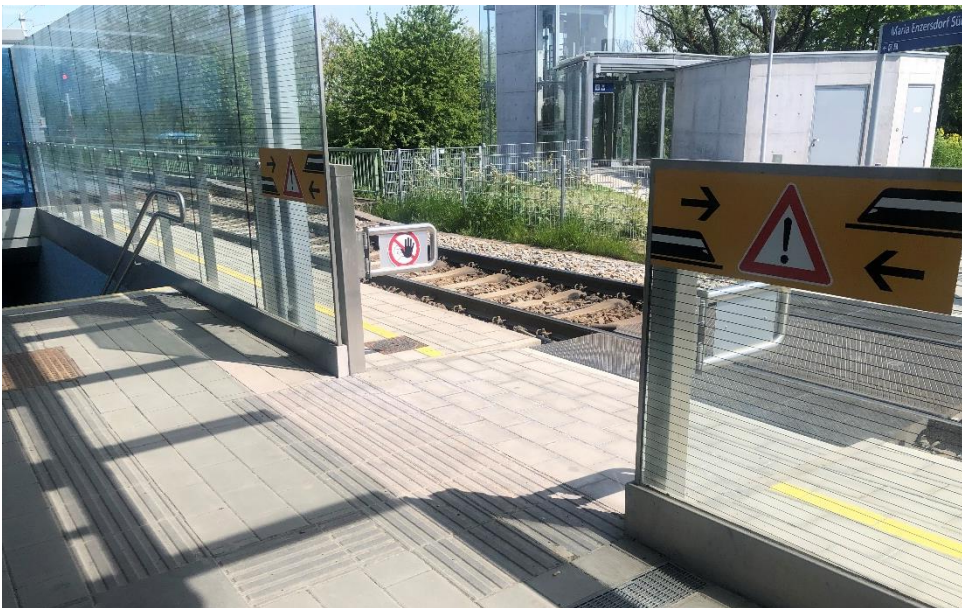
Abbildung 2: Schienengleicher Bahnsteigzugang in der modernisierten Haltestelle Maria Enzersdorf Südost am 5. Mai 2023
