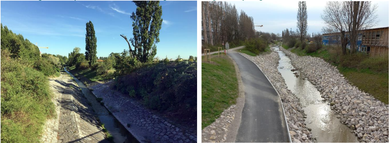
Abbildung 3: Beispiel der Renaturierung am Liesingbach (Vergleich vorher-nachher)
