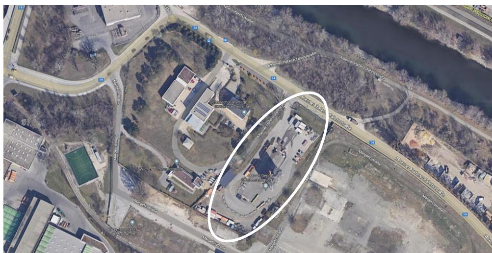
Abbildung 14: Lager Wien 11, Alberner Hafenzufahrtsstraße 10
