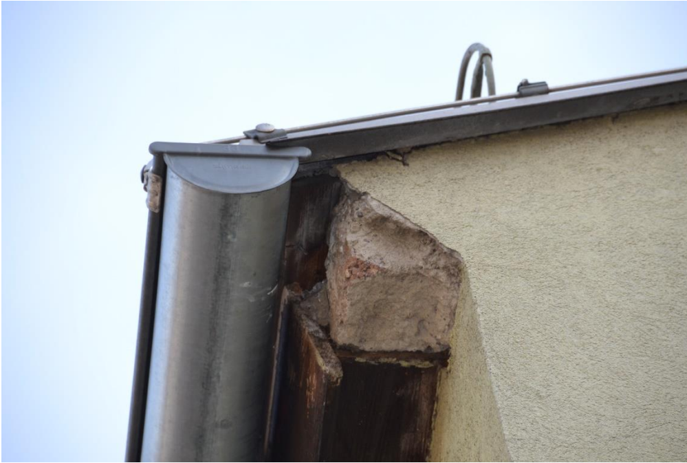
Abbildung 4: Lockeres Fassadengesims
