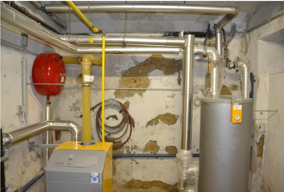
Abbildung 8: Feuchteschaden
