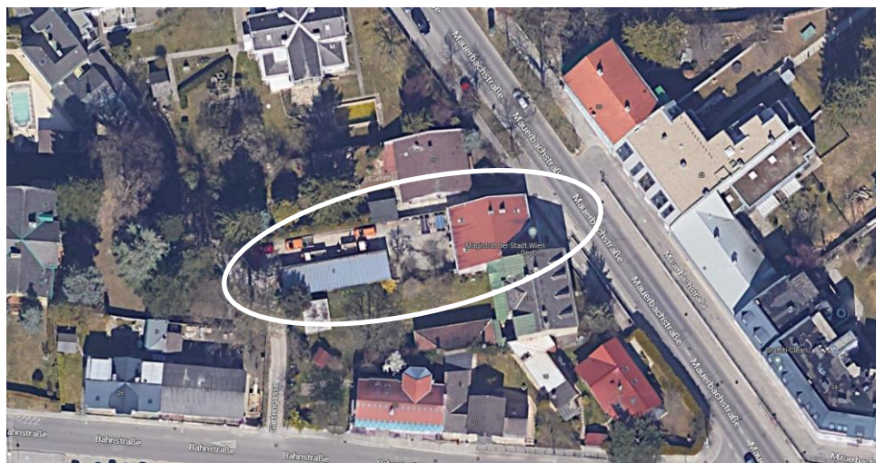
Abbildung 6: Unterkunft der Straßenreinigung - Wien 14, Mauerbachstraße 27
