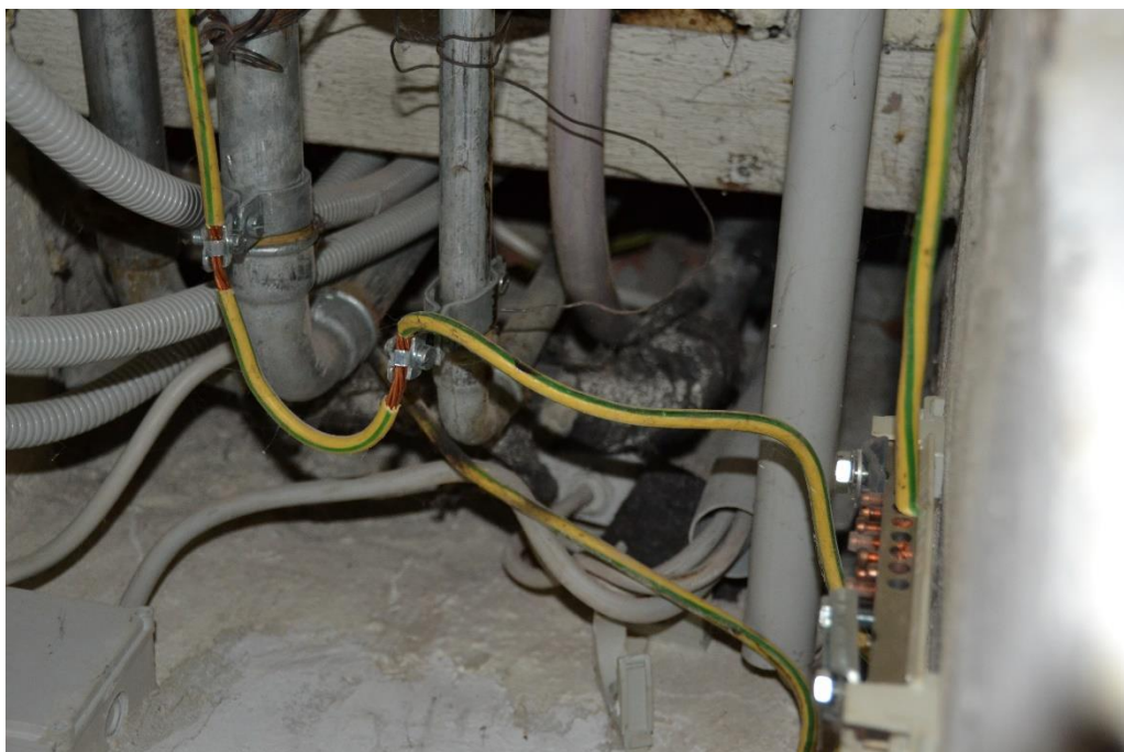
Abbildung 3: Unterbrochener Brandabschnitt
