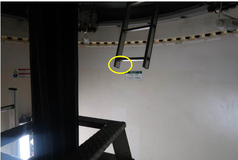
Abbildung 12: Leiter ins Maschinenhaus, scharfkantiger Abschluss
