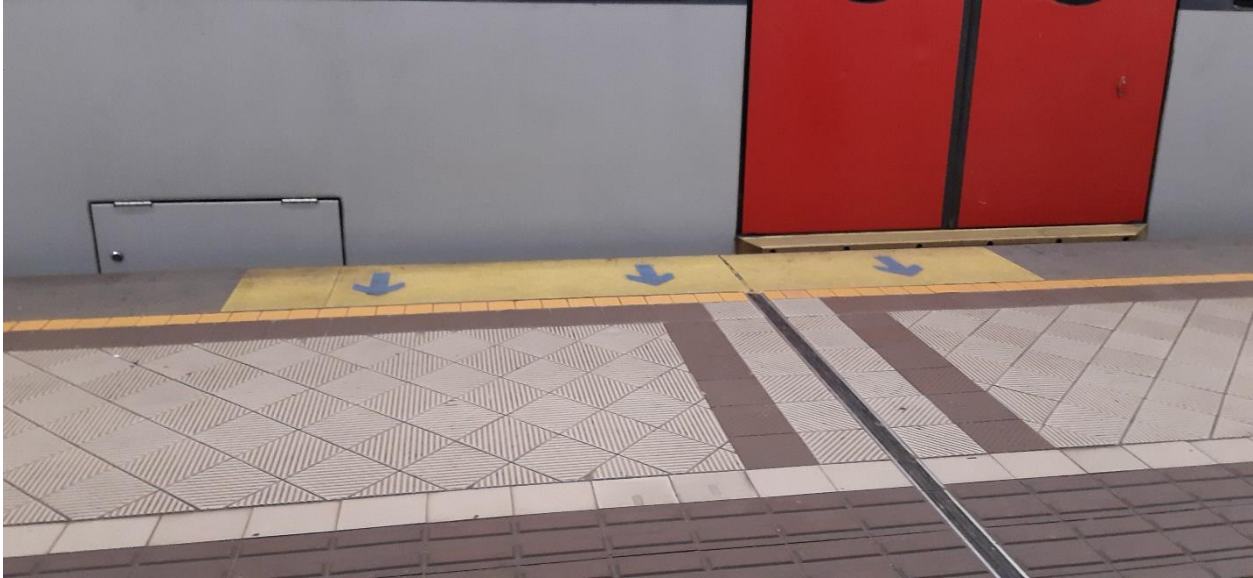
Abbildung 3: Abweichung zwischen Türposition und Bodenmarkierung zur Beschleunigung des Fahrgastwechsels in der Station Längenfeldgasse der U-Bahn-Linie U6
