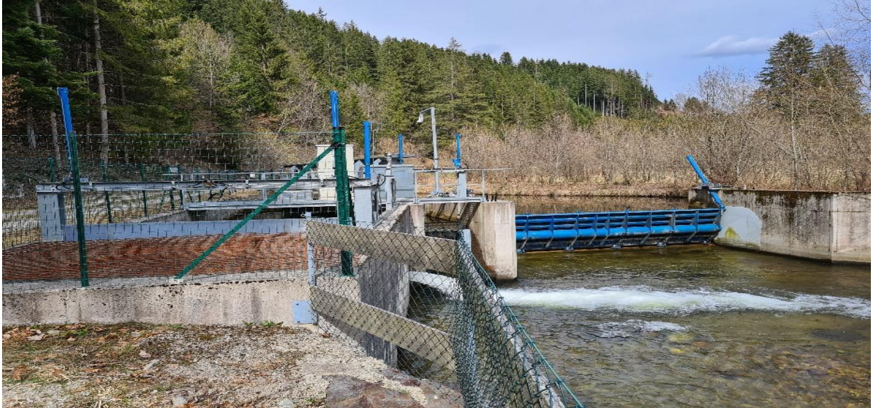
Abbildung 18: Kraftwerk Ratten - Wehranlage
