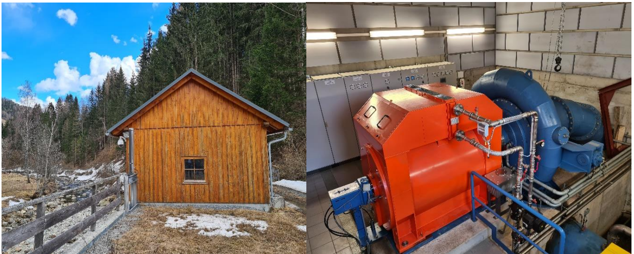
Abbildung 7: Kraftwerk Rantenbach - Krafthaus
