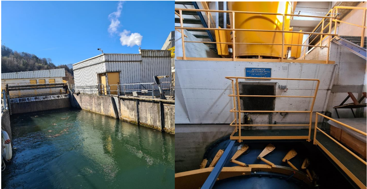
Abbildung 1: Kraftwerk Berndorf bzw. Kraftwerk Norske Skog - Außen- und Innenansicht
