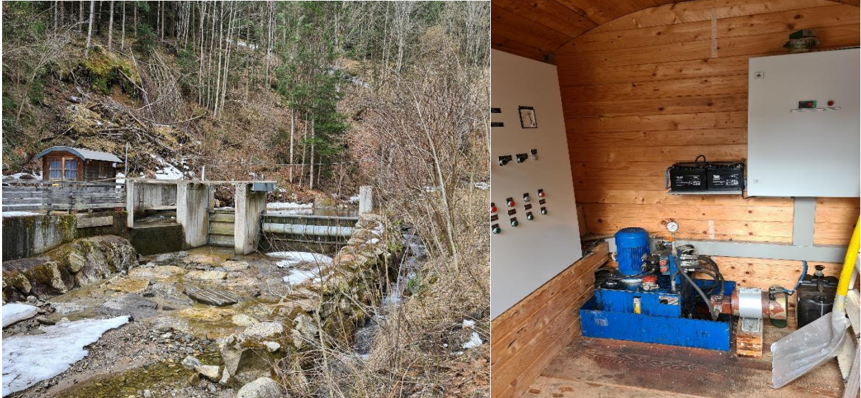
Abbildung 10: Kraftwerk Lavantegg - Wehranlage und Wehrhaus
