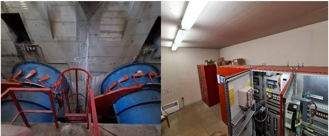
Abbildung 5: Kraftwerk Unzmarkt - Innenansicht
