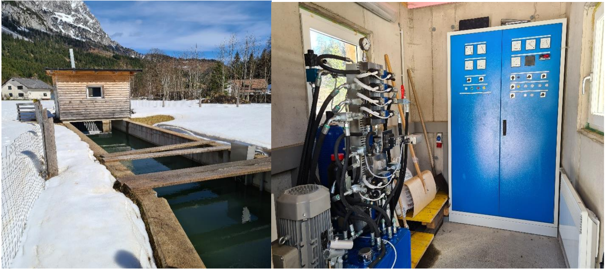
Abbildung 2: Kraftwerk Radmerbach - Wehrhaus
