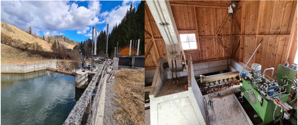
Abbildung 6: Kraftwerk Rantenbach - Wehranlage und Wehrhaus
