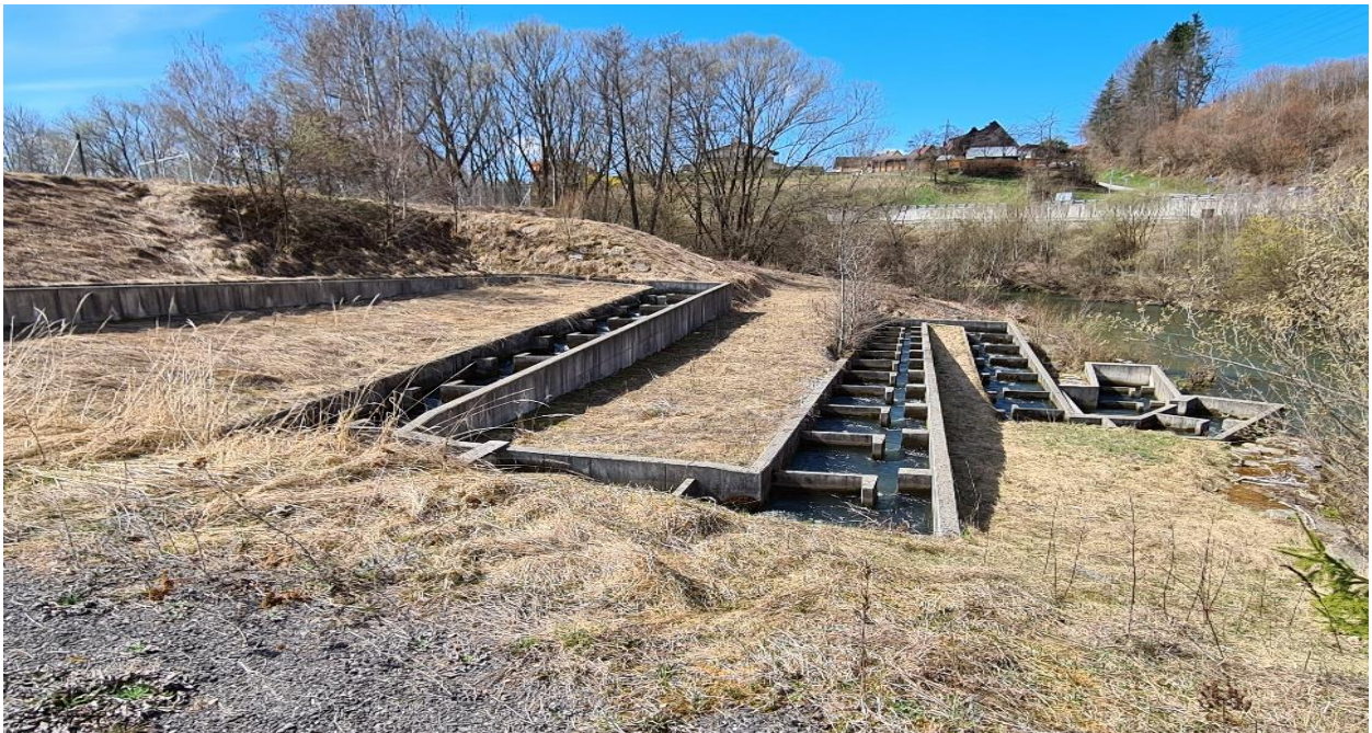
Abbildung 17: Kraftwerk Kindberg-Aumühl - Fischaufstiegshilfe
