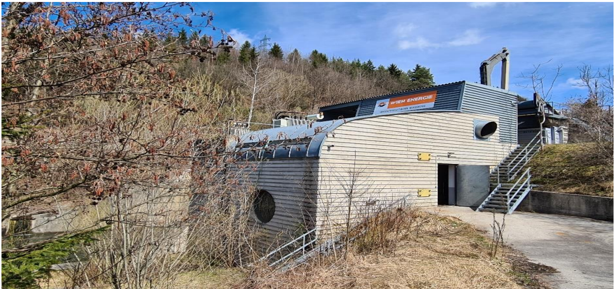
Abbildung 15: Kraftwerk Kindberg-Aumühl - Außenansicht
