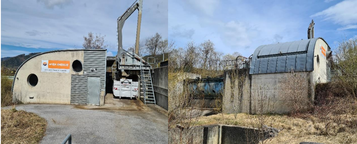
Abbildung 12: Kraftwerk Mürzhofen - Außenansicht
