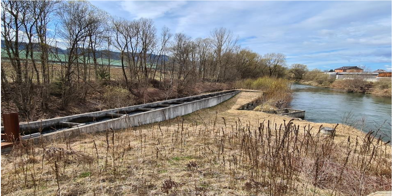
Abbildung 14: Kraftwerk Mürzhofen - Fischaufstiegshilfe
