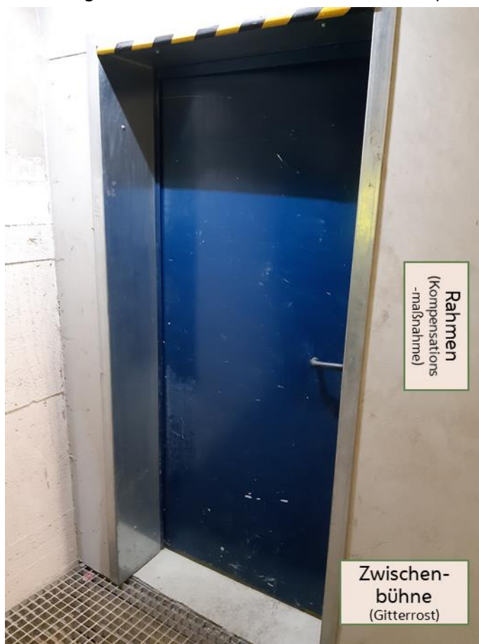
Abbildung 3: Wanddurchbruch mit Tür sowie Kompensationsmaßnahme und Gitterrost
