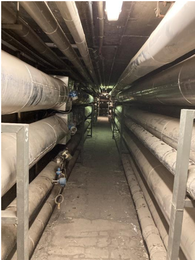
Abbildung 7: Kollektorgang unterhalb der MVA Flötzersteig
