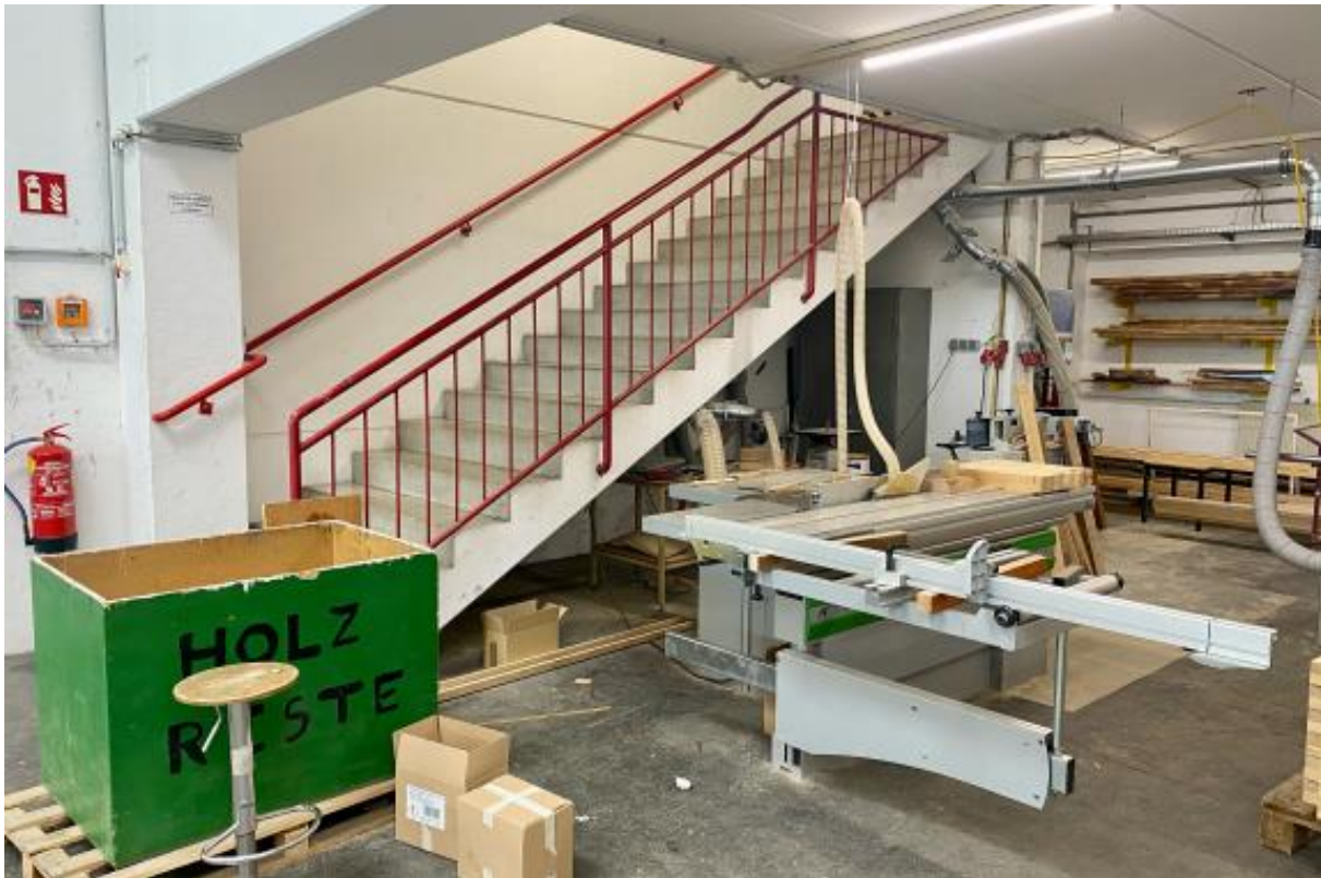
Abbildung 3: Fluchttreppe im hinteren Hallenteil
