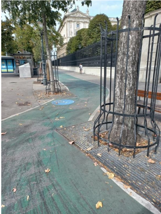
Abbildung 4: Radweg kreuzt die Baumgitter (Wien 1, Burgring gegenüber Eschenbachgasse)
