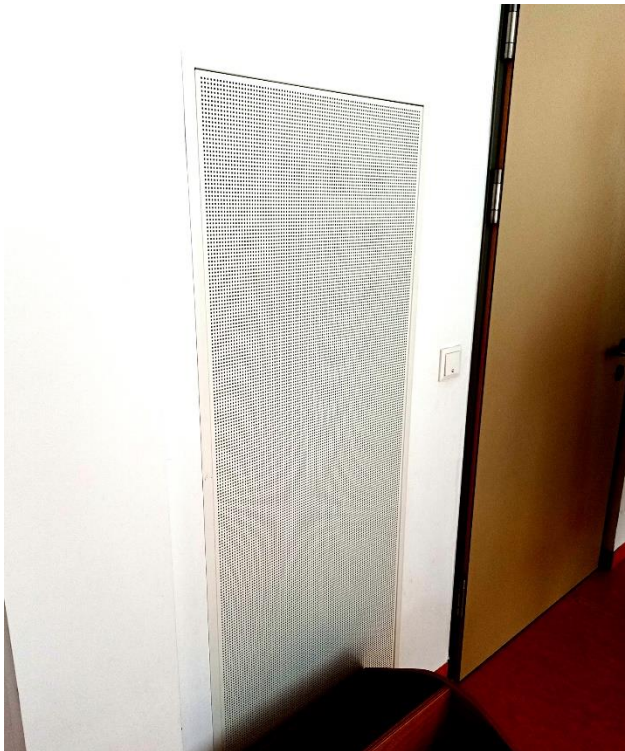
Abbildung 7: Lochblech der Belüftung
