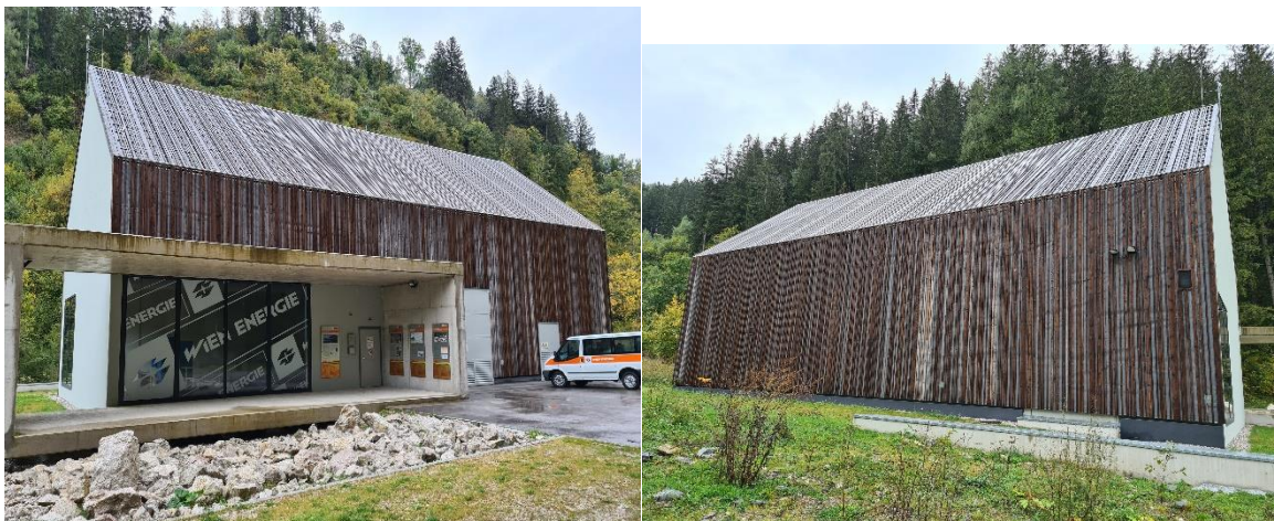
Abbildung 2: Kraftwerkshaus - Außenansicht Eingangsbereich und Außenansicht flussseitig
