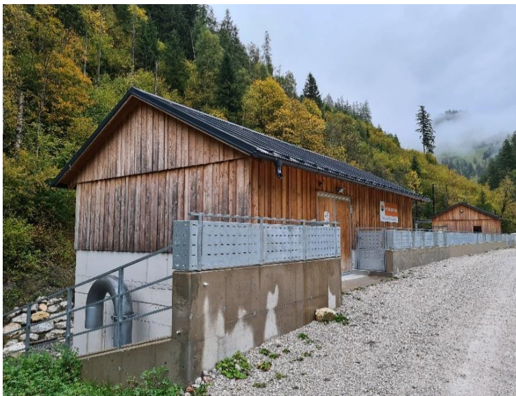
Abbildung 9: Wehranlage: Rechenhaus vorne und Wehrhaus hinten
