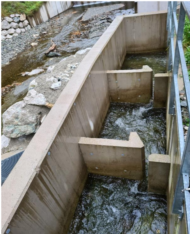
Abbildung 12: Fischwanderhilfe unterer Teil
