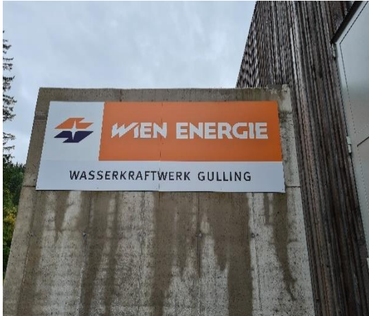
Abbildung 1: Firmenschild am Kraftwerkshaus des Kleinwasserkraftwerkes an der Gulling
