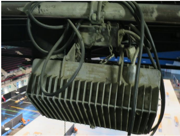
Abbildung 3: Leuchte mit zweiter Tragvorrichtung (Kette)
