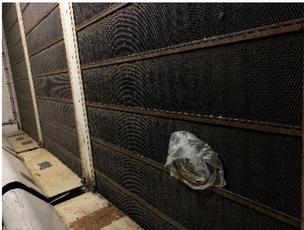
Abbildung 15: Ölumlauffilter
