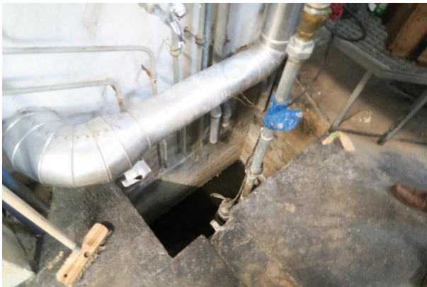
Abbildung 12: Pumpensumpf
