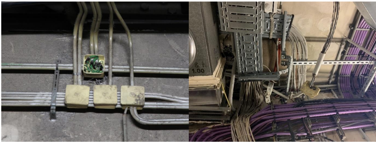
Abbildung 9: offene und nicht befestigte Verteildosen
