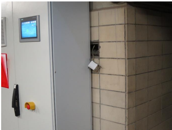
Abbildung 4: lose Aufputzsteckdose
