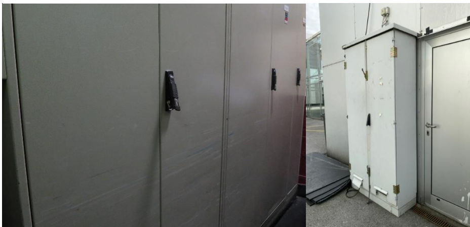
Abbildung 6: unversperrte Elektroverteilschränke
