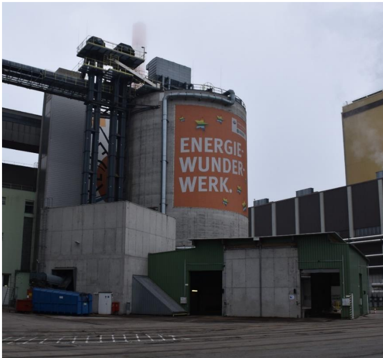
Abbildung 2: Entladegasse und Silo
