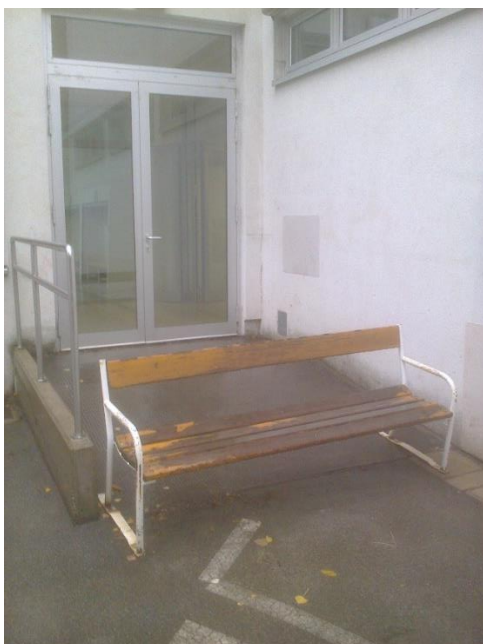
Abbildung 38: Verstellter Verkehrsweg in den Schulpark, Schulstandort 11
