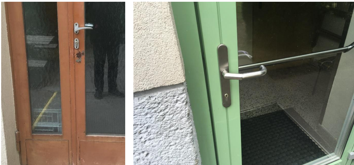
Abbildung 21: links: spitze Türdrücker, rechts: nach hinten gebogene Türdrücker, Schulstandort 5
