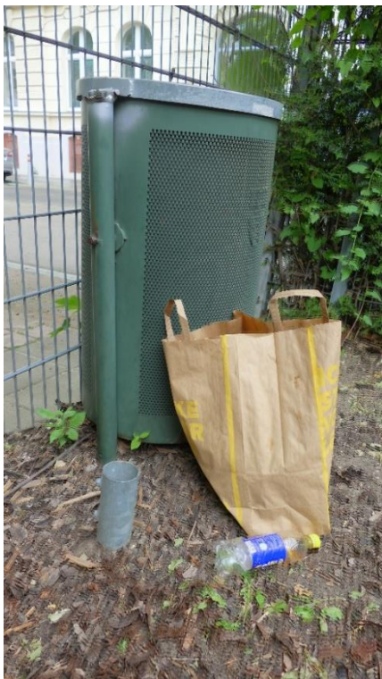
Abbildung 7: Rohrstummel nahe der Aufprallfläche eines Spielplatzgerätes, Schulstandort 2
