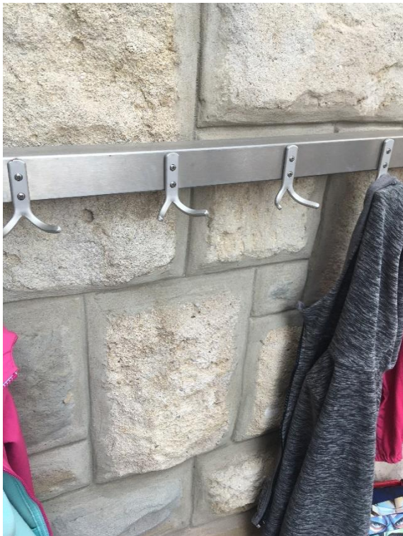
Abbildung 12: Nach außen gebogene Garderobehaken, Schulstandort 3
