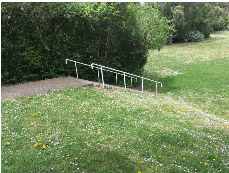
Abbildung 36: Außenstiegenanlage mit einläufigen Handläufen, Schulstandort 10
