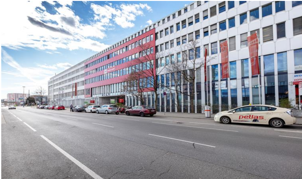
Abbildung 1: Direktionsgebäude - Außenansicht Wien 3, Erdbergstraße
