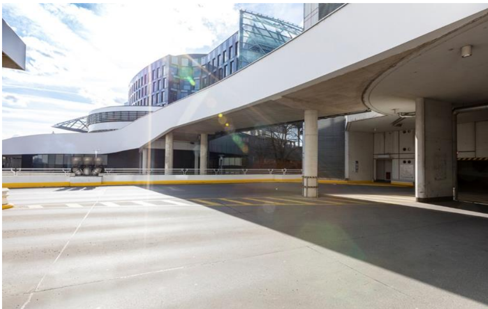
Abbildung 10: Brückenkonstruktion als Übergang zur Verbindung zum angrenzenden Gebäude
