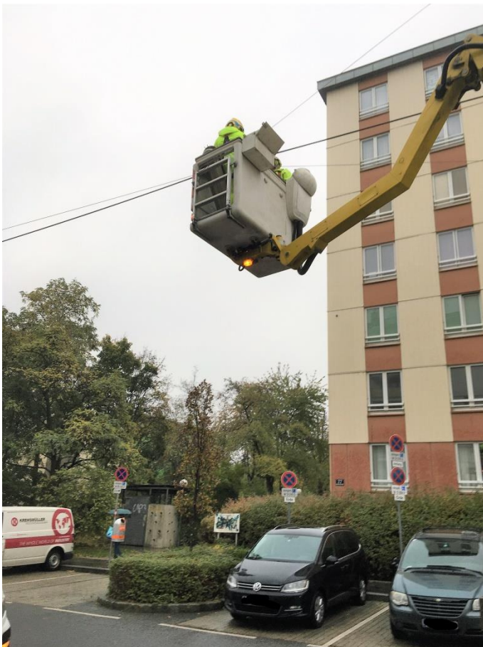
Abbildung 2: Arbeiten an der öffentlichen Beleuchtung im Straßenraum
