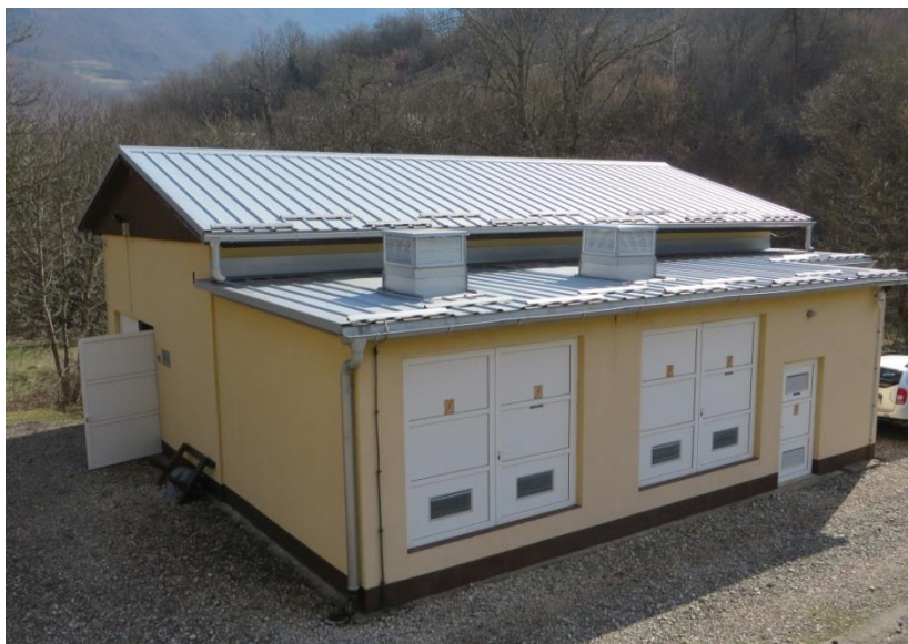
Abbildung 14: Kraftwerk Sućeska RS-1 - Außenansicht
