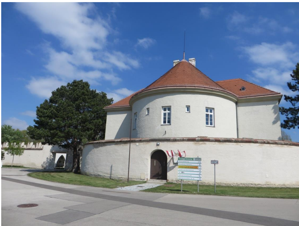
Abbildung 2: Verwaltungsgebäude Friedhof Feuerhalle Simmering - Außenansicht
