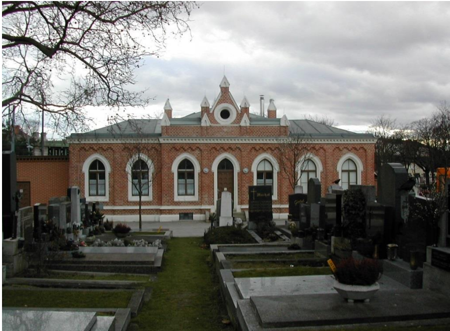
Abbildung 35: Arbeiterunterkunft am Friedhof Hernals - Außenansicht
