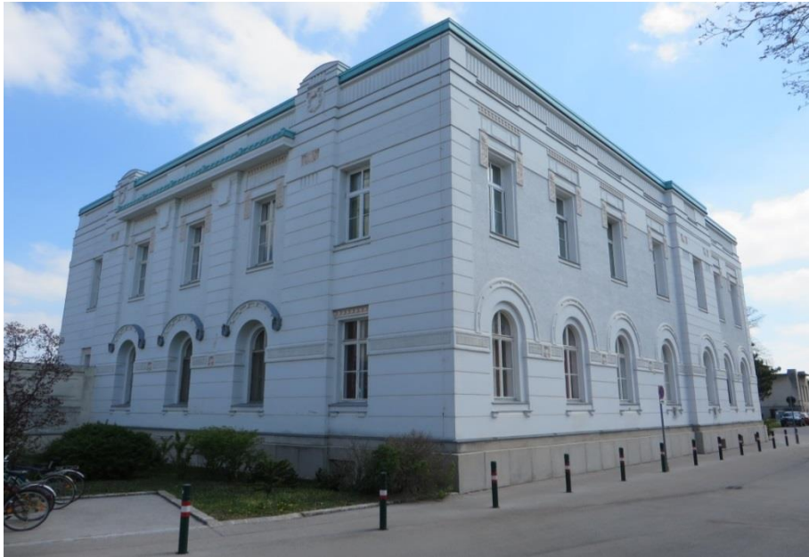
Abbildung 14: Linkes Wohngebäude am Wiener Zentralfriedhof - Außenansicht
