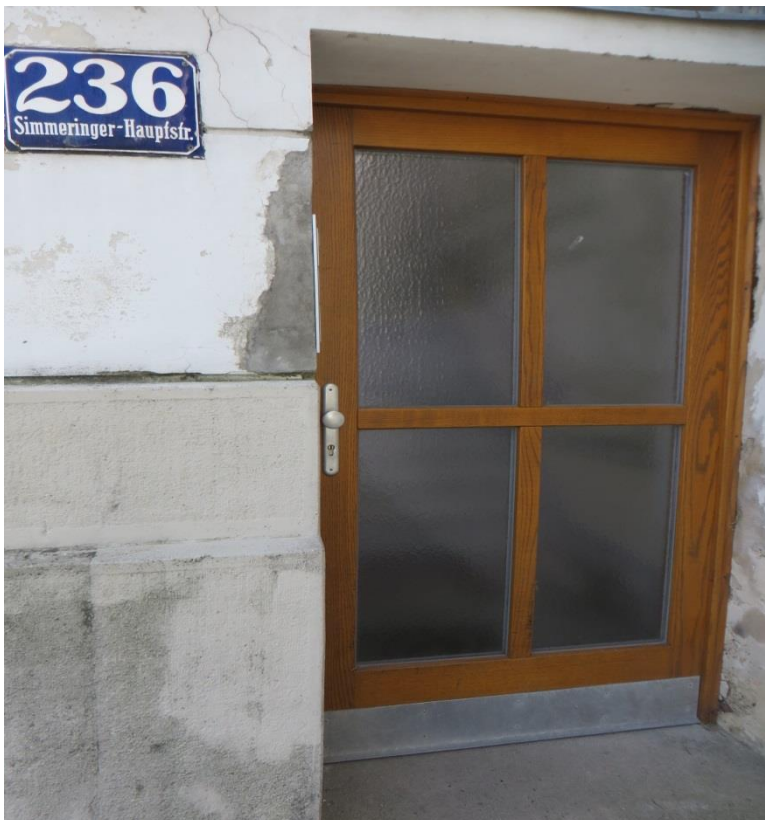
Abbildung 15: Linkes Wohngebäude am Wiener Zentralfriedhof - straßenseitiger Eingang
