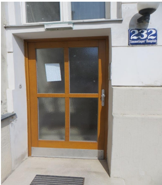
Abbildung 13: Rechtes Wohn- und Verwaltungsgebäude am Wiener Zentralfriedhof - straßenseitiger Eingang
