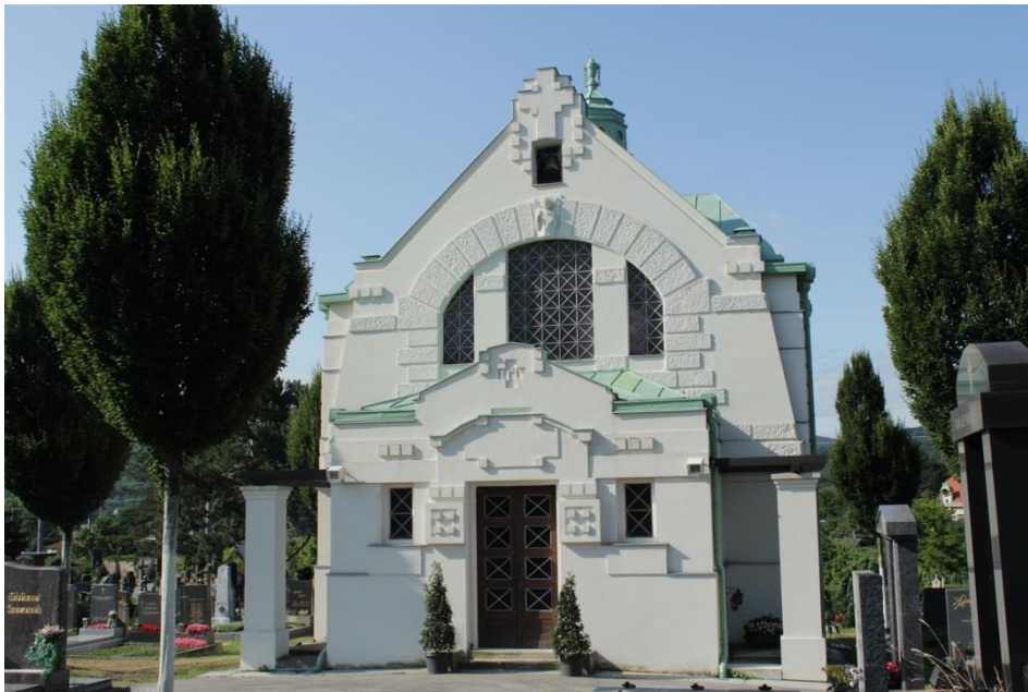
Abbildung 27: Gruft- bzw. Friedhofskapelle Friedhof Hadersdorf-Weidlingau - Außenansicht
