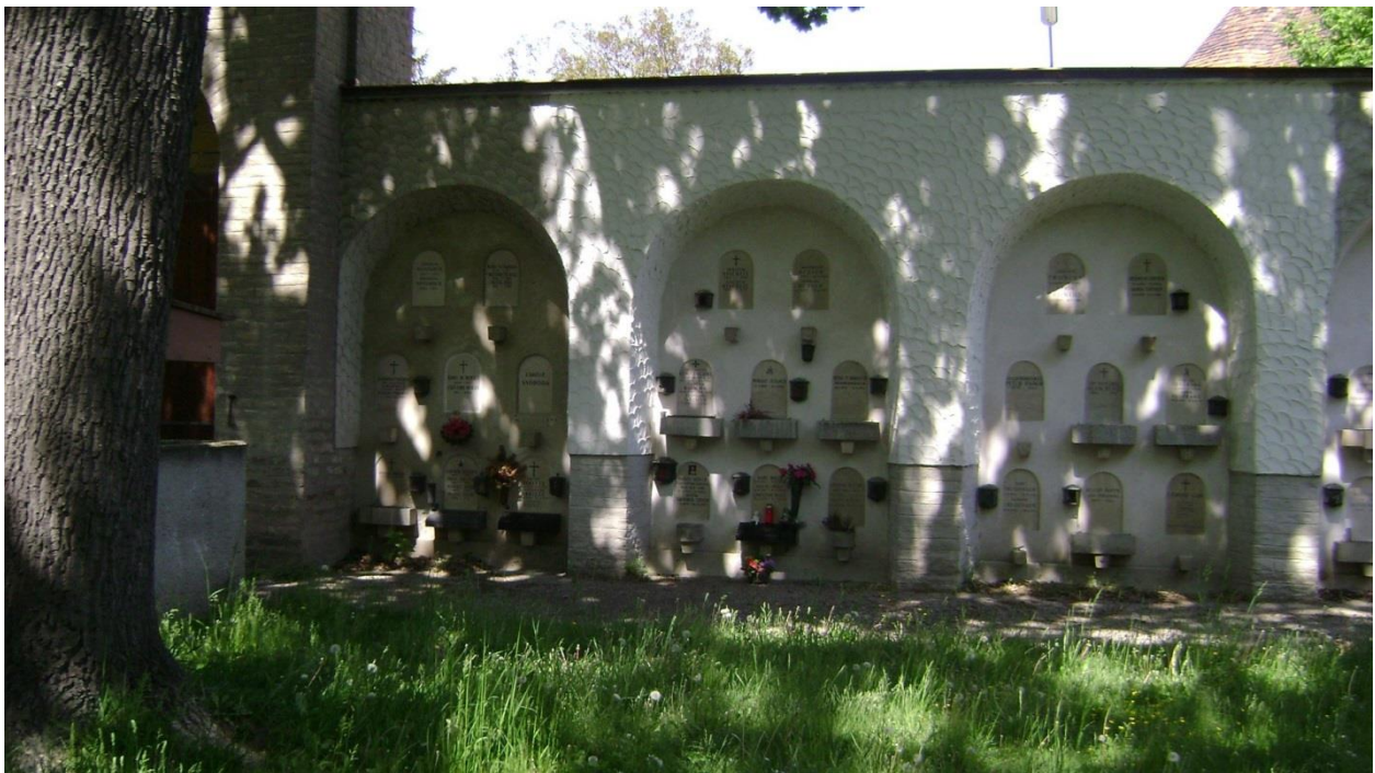
Abbildung 5: Einfriedungsmauer Friedhof Feuerhalle Simmering
