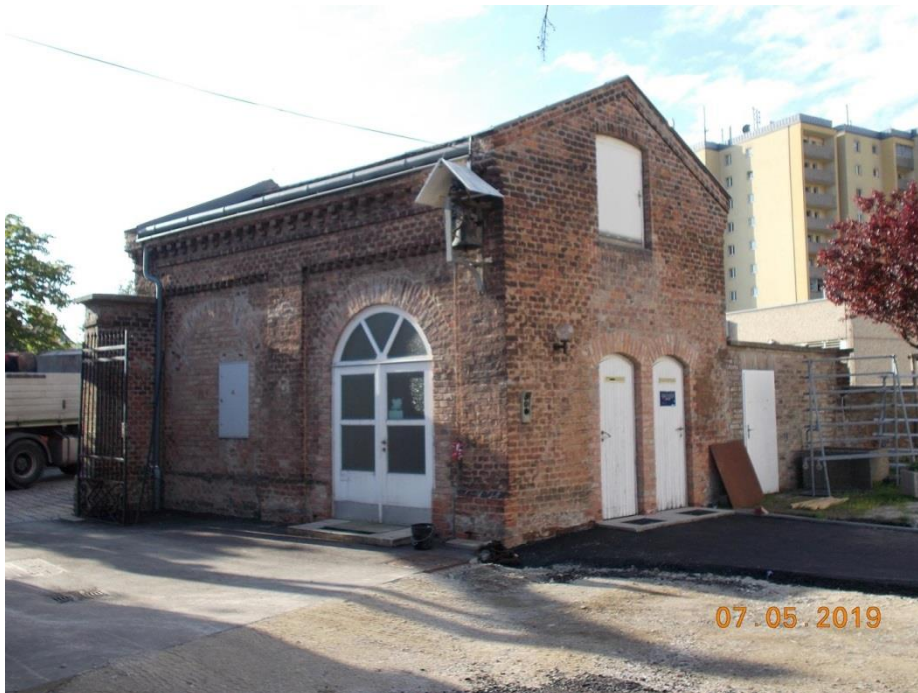
Abbildung 9: Nebengebäude Friedhof Kaiserebersdorf - Außenansicht
