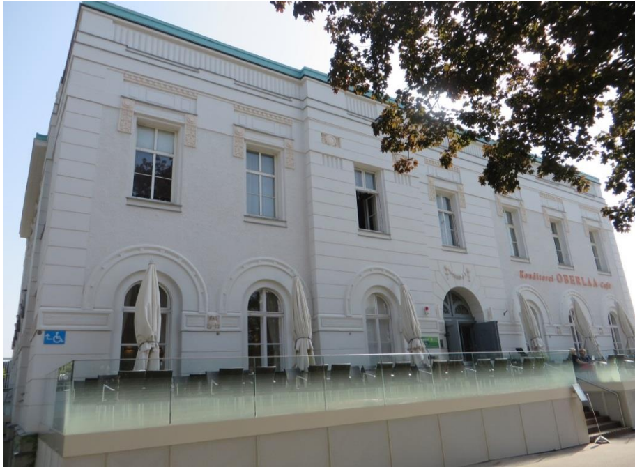
Abbildung 12: Rechtes Wohn- und Verwaltungsgebäude am Wiener Zentralfriedhof - Außenansicht
