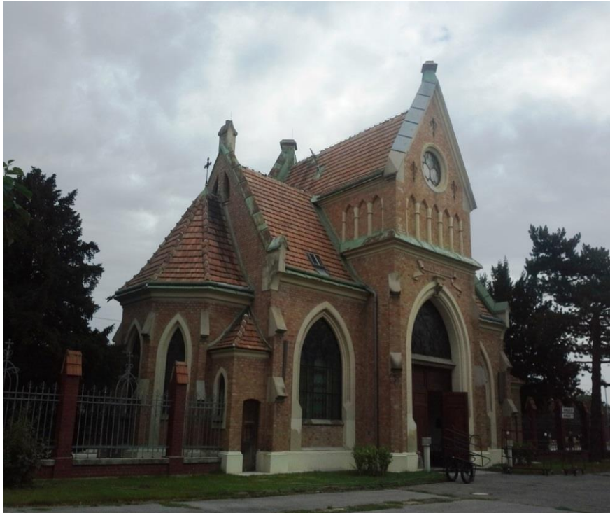
Abbildung 41: Aufbahrungshalle 1 Stammersdorfer Zentralfriedhof - Außenansicht
