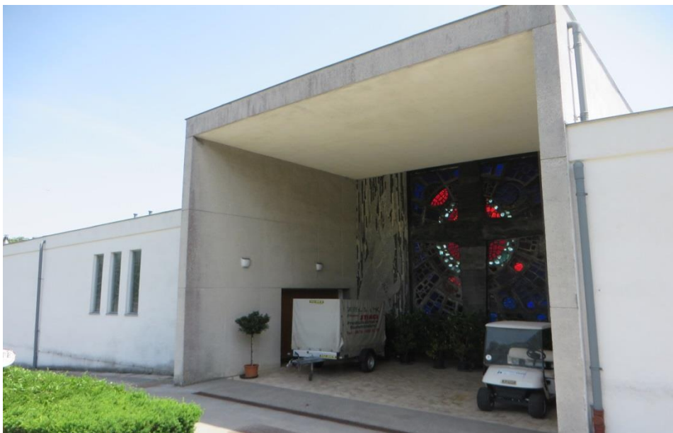
Abbildung 25: Aufbahrungshalle Friedhof Ober St. Veit - Außenansicht
