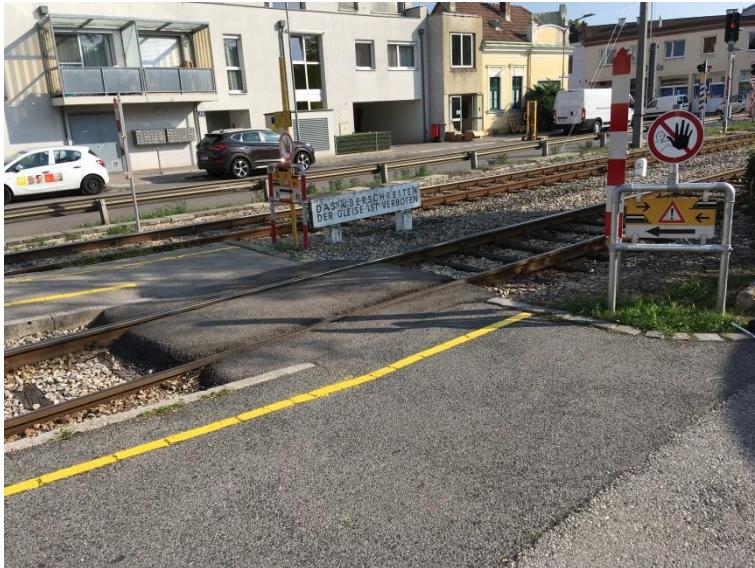
Abbildung 10: Schienengleicher Bahnsteigzugang im Bahnhof Traiskirchen Lokalbahn, aufgenommen am 26. August 2019
