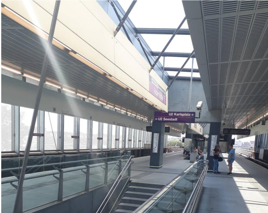
Abbildung 11: Bahnsteig der Station Aspernstraße
