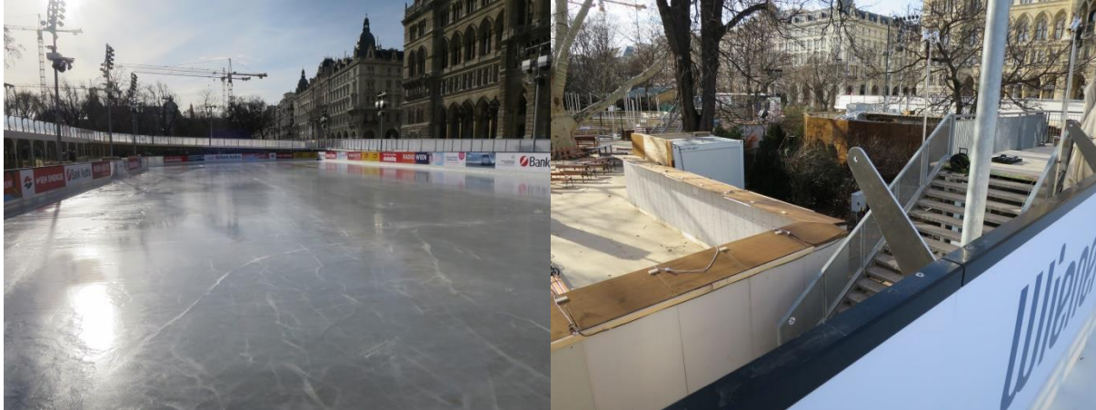
Abbildungen 5 und 6: Rampe und Fluchtstiege
