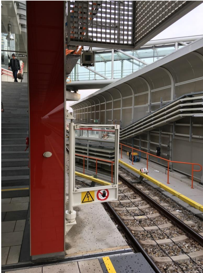
Abbildung 3: Spiegel als Abfertigungshilfe in der Station Oberlaa der U-Bahnlinie U1 für in der Endstation ankommende Züge
