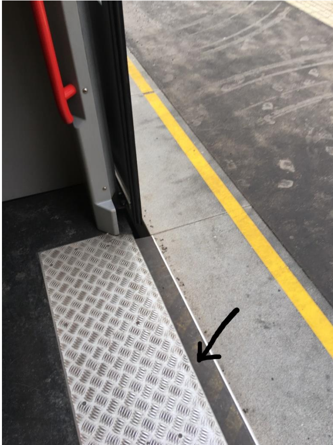
Abbildung 5: Spaltüberbrückung an einer Türöffnung des U-Bahn-Zuges vom Wagentyp "V" während eines Aufenthaltes in der U-Bahn-Station Stadtpark Fahrtrichtung Hütteldorf
