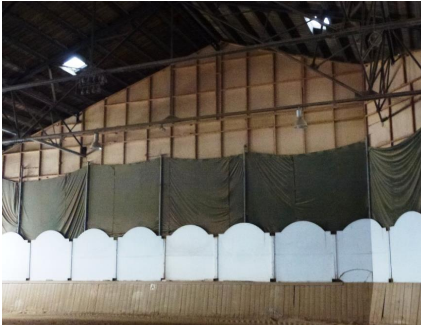
Abbildung 13: Holzständerwand als Trennung innerhalb der alten Reithalle
