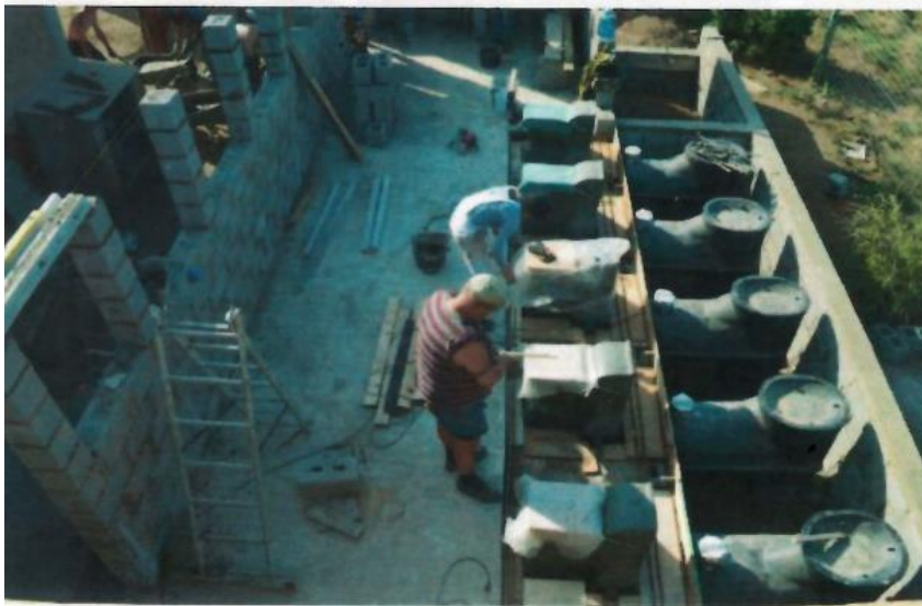
Rohbau Toilettenanlage
