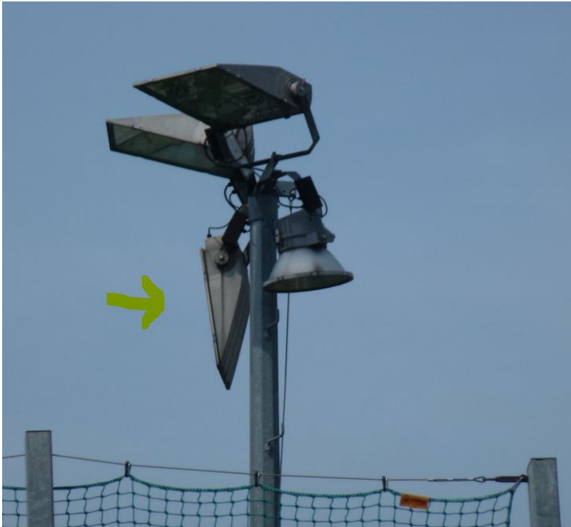
Abbildung 3: Planflächenstrahler, entgegen der Montagevorschrift befestigt (gelber Pfeil)
