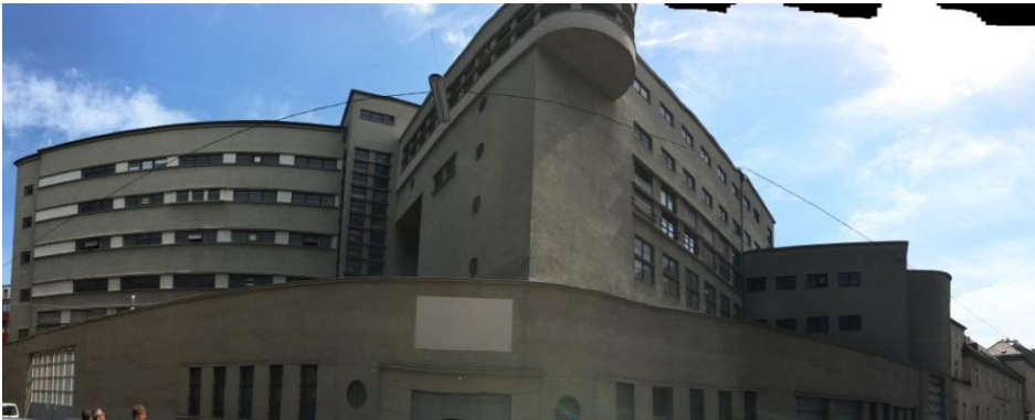
Abbildung 12: Umspannwerk Favoriten - Außenansicht 1
