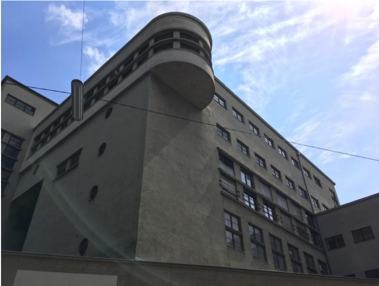
Abbildung 14: Umspannwerk Favoriten - Außenansicht 3
