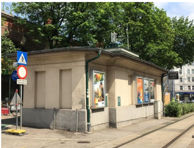
Abbildung 20: Gasdruckregelgebäude Währing - Außenansicht 1
