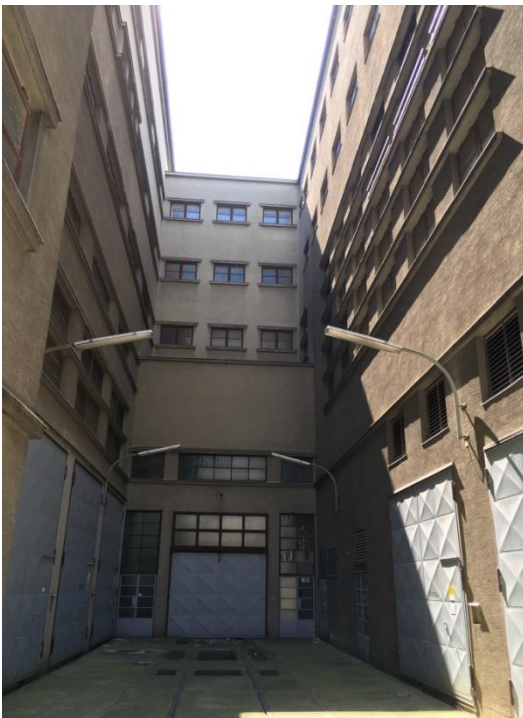
Abbildung 13: Umspannwerk Favoriten - Außenansicht 2 Innenhof
