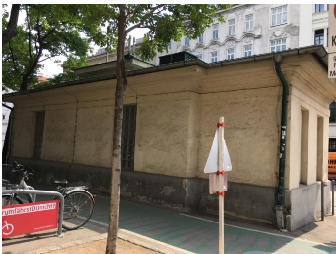
Abbildung 21: Gasdruckregelgebäude Währing - Außenansicht 2
