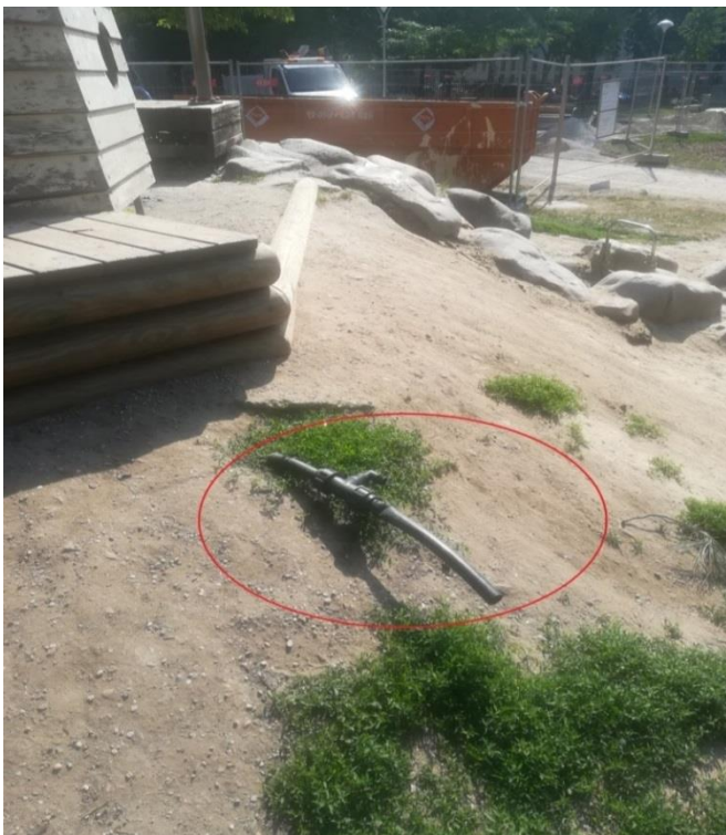
Abbildung 5: Stolperfalle durch Bewässerungsschlauch im Bereich "Leuchtturm", Wasserspielplatz Max-Winter-Park (exemplarisch)
