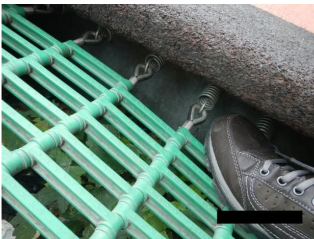
Abbildung 5: Bodentrampolin, allfällige Verletzungsgefahr im Randbereich infolge Einklemmen bzw. Quetschen (exemplarisch)
