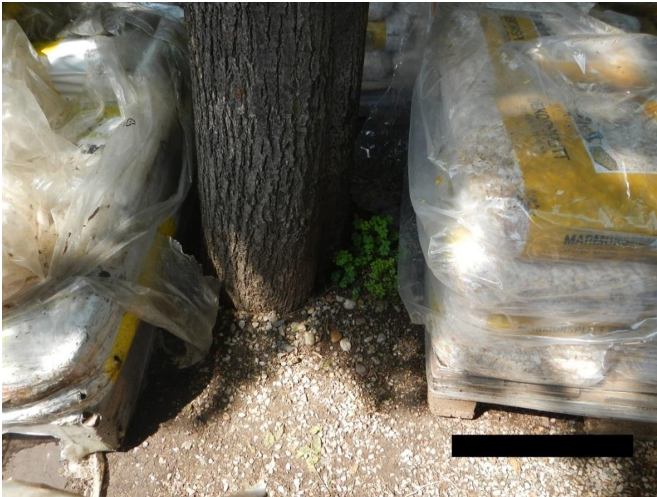
Abbildung 17: Lagerung im Schutzbereich
