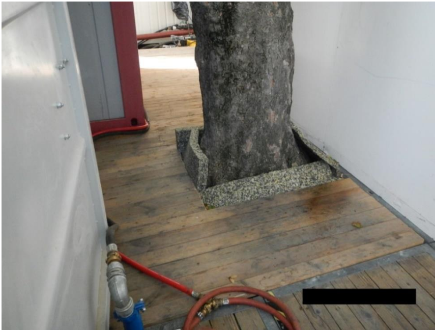
Abbildung 8: Fehlender Stammschutz
