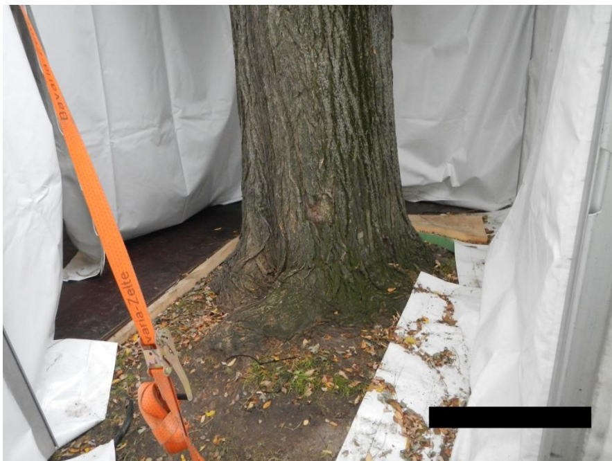
Abbildung 12: Gefährdung des Wurzelbereiches durch Aufbauten
