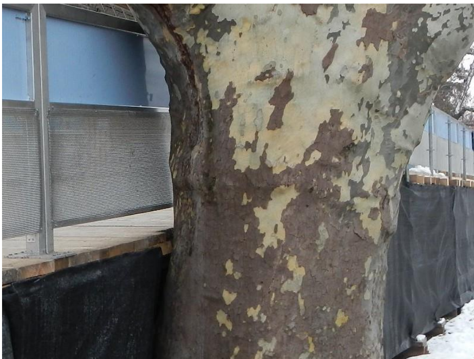
Abbildung 7: Fehlender Stammschutz
