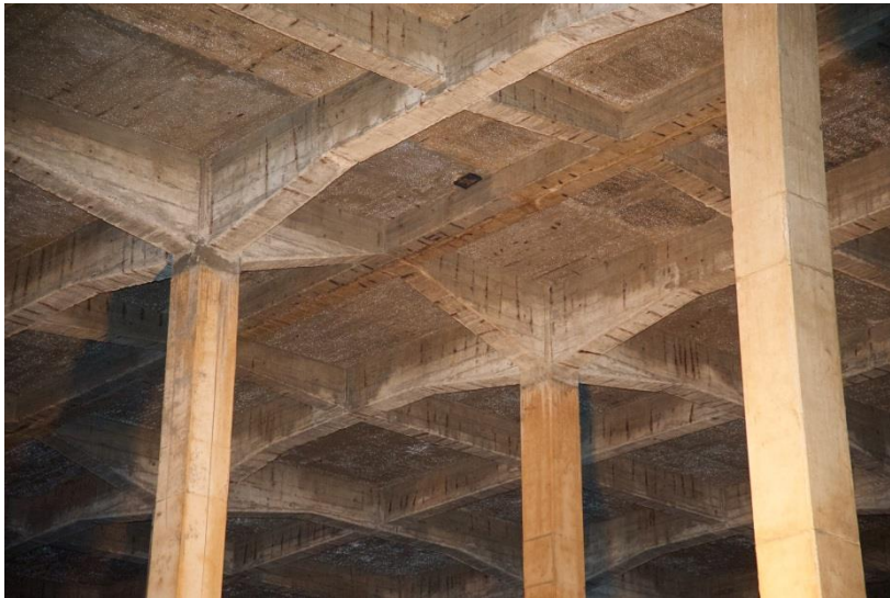
Abbildung 6: Deckenkonstruktion der Kammer C
