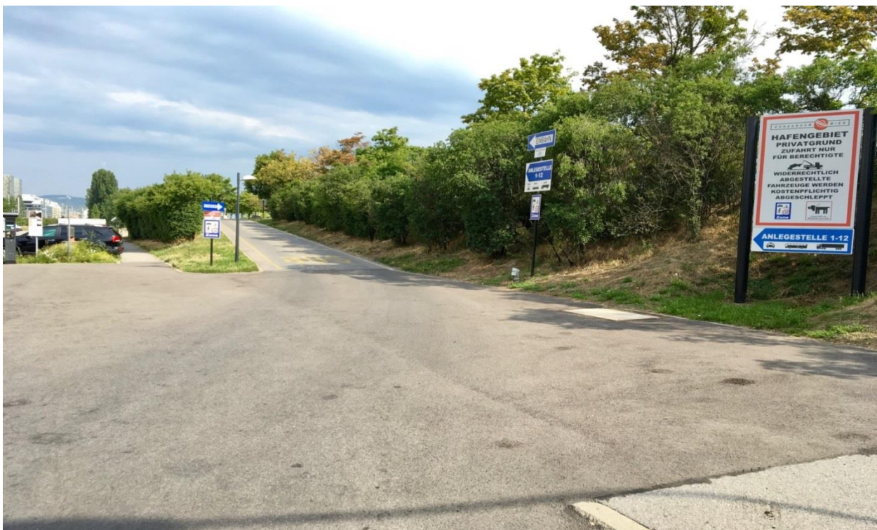
Abbildung 2: Auffahrtsrampe nach der Zufahrt vom Handelskai
