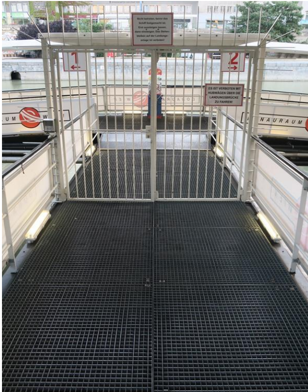
Abbildung 6: Zugangssteg mit Gitterrostauflage
