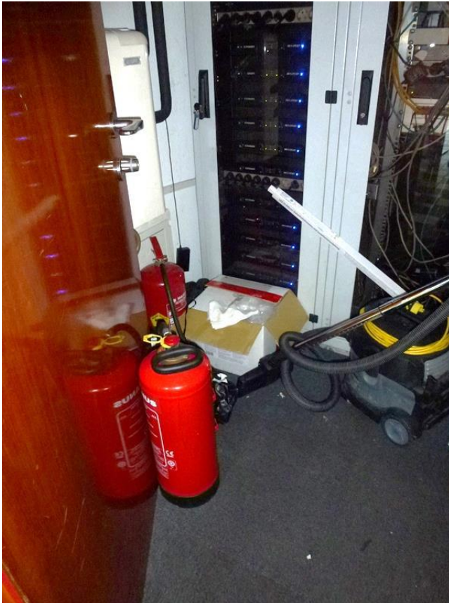
Abbildung 3: Offen gehaltene Feuerschutztür
