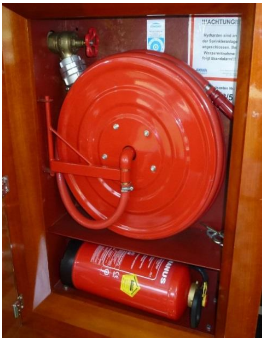
Abbildung 4: Wandhydrantenkasten
