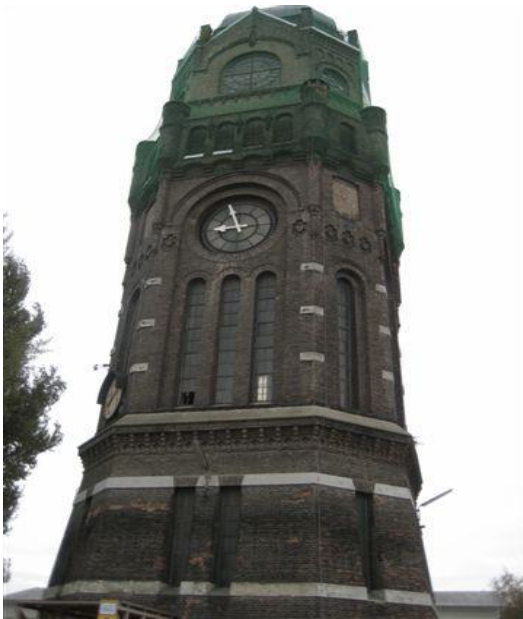
Abbildung 1: Wasserturm vor der denkmalpflegerischen Instandsetzung
