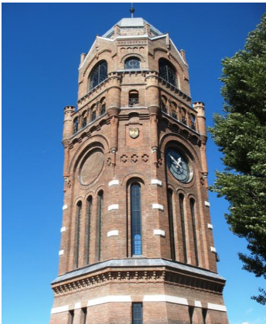
Abbildung 2: Wasserturm nach der denkmalpflegerischen Instandsetzung
