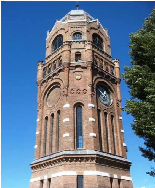
Abbildung 2: Wasserturm nach der denkmalpflegerischen Instandsetzung
