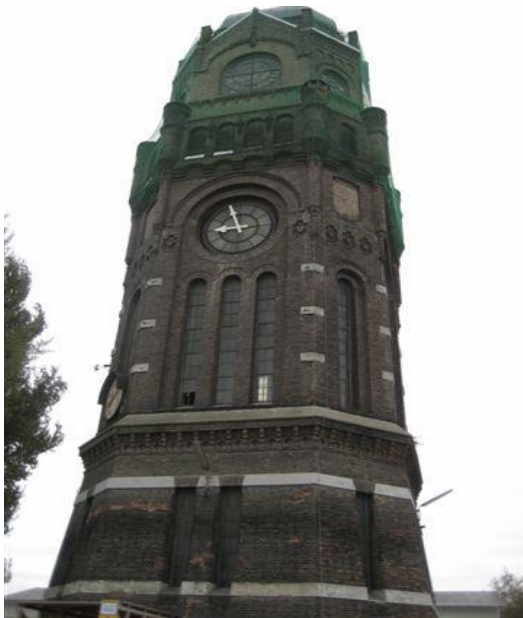
Abbildung 1: Wasserturm vor der denkmalpflegerischen Instandsetzung
