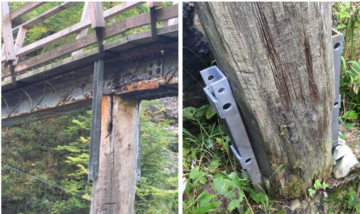
Abbildungen 8 und 9: Klausgrabensteg Mittelstütze - Ausführung nach Sanierung
