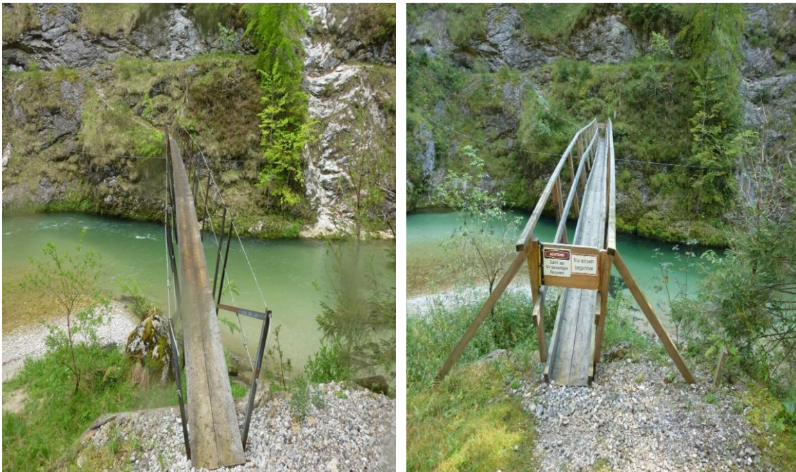
Abbildungen 10 und 11: Klausgrabensteg - Ausführung vor und nach Sanierung
