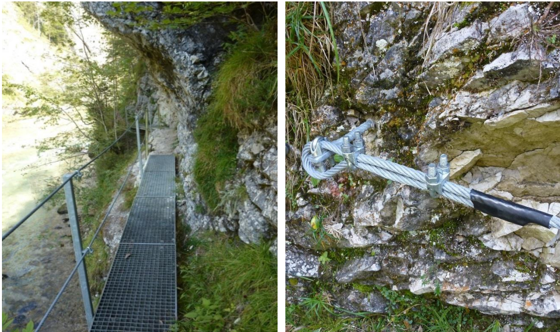
Abbildungen 4 und 5: Klausgrabensteig - Sicherung gefährlicher Passagen
