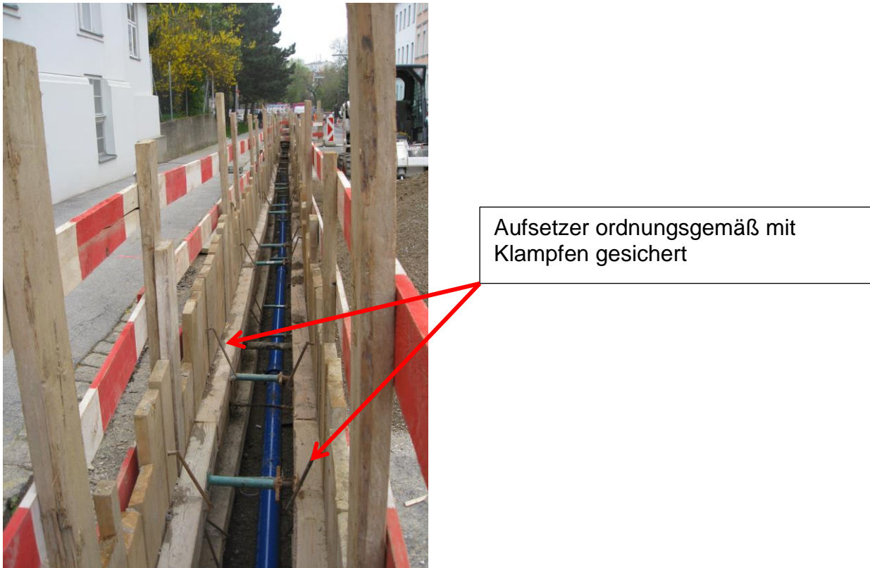
Abbildung 4: ordnungsgemäße Künetten- und Baustellenabsicherung
