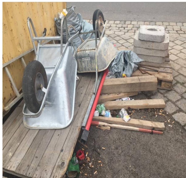
Abbildungen 1 und 2: Im Sinn der ÖNORM V 2104 mangelhaft gesicherte Lagerungen
