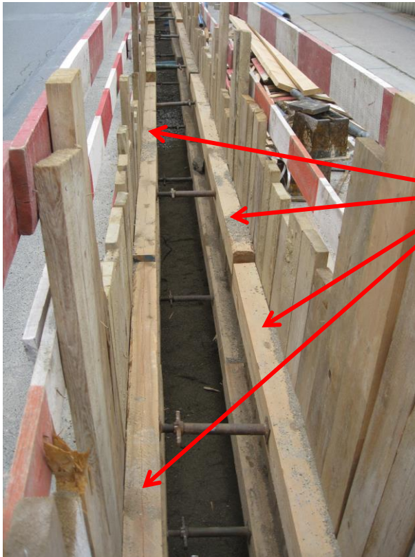
Abbildung 7: Künette mit fehlenden Hängeeisen
