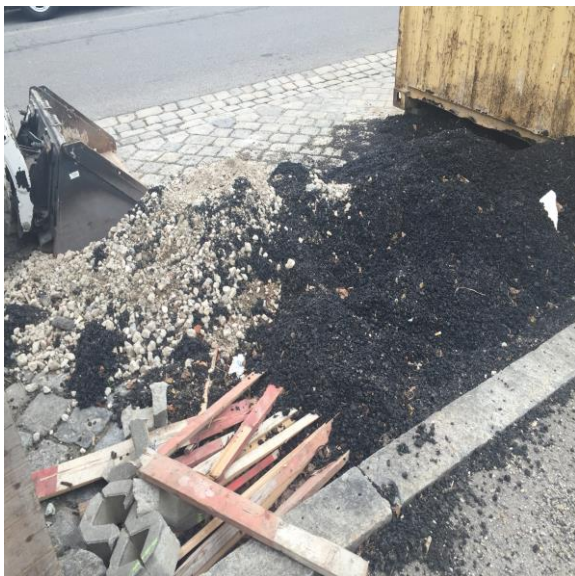
Abbildungen 1 und 2: Im Sinn der ÖNORM V 2104 mangelhaft gesicherte Lagerungen
