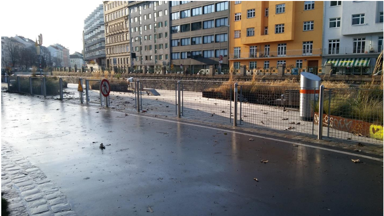
Abbildung 5: Poller samt angebrachter Gitterelemente
