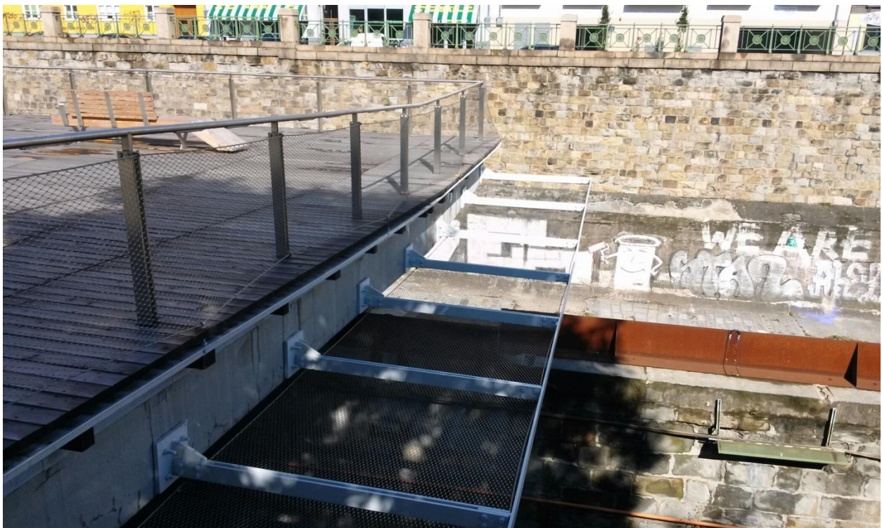
Abbildung 4: Geländer und Abwurfsicherung
