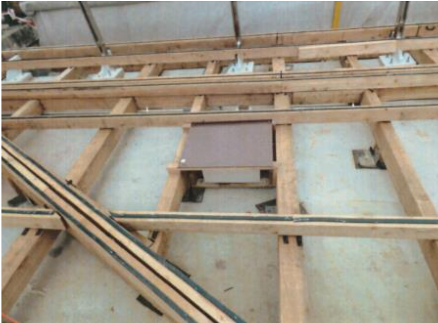
Abbildung 12: Holzunterkonstruktion der Wientalerrasse
