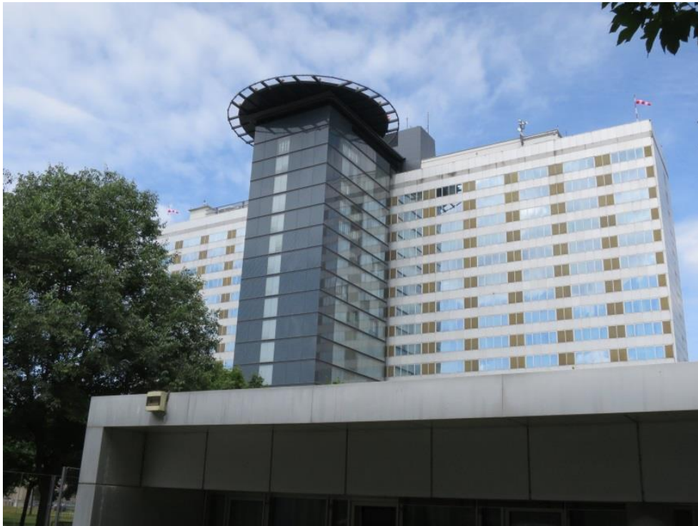
Abbildung 2: Krankenanstalt Rudolfstiftung mit Hubschrauberlandeplatz
