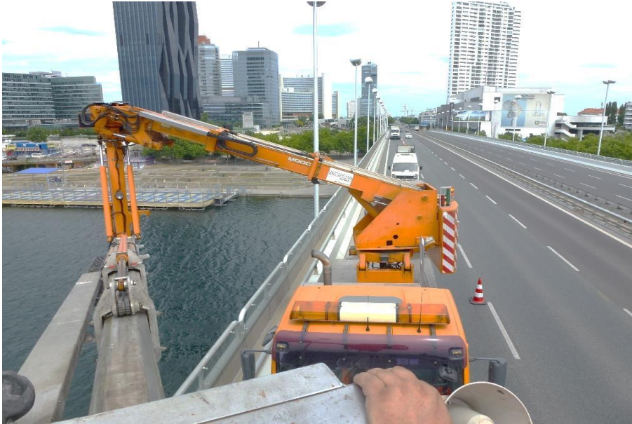
Abbildung 18: Brückenprüfgerät und Abdeckwagen auf der Reichsbrücke
