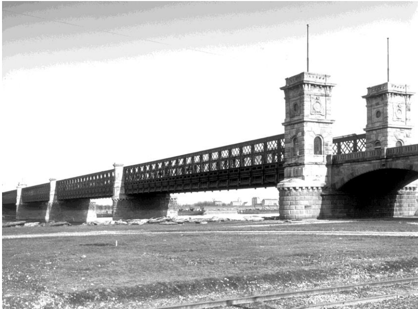
Abbildung 1: Die erste Reichsbrücke (Kronprinz-Rudolf-Brücke)
