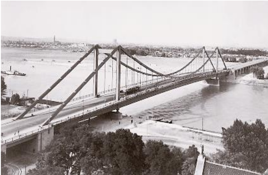
Abbildung 2: Die zweite Reichsbrücke
