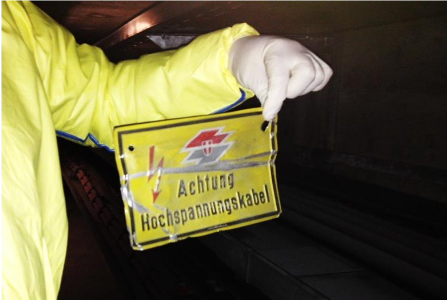
Abbildung 13: Nicht montiertes Warnschild
