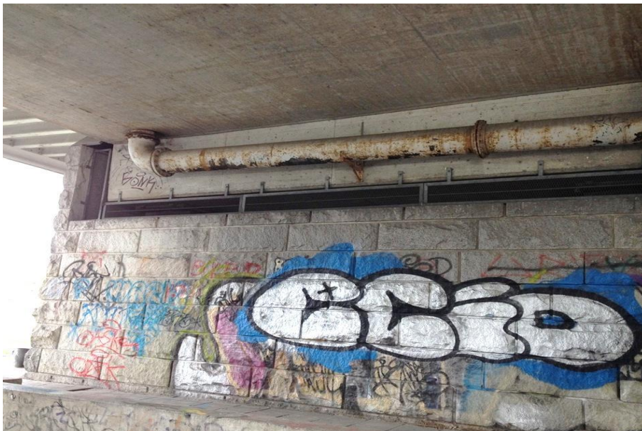
Abbildung 7: Wasserleitungsrohr unter dem Tragwerk im Bereich des Donauinselpfeilers
