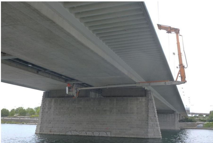
Abbildung 17: Kontrolle mit Brückenprüfgerät im Bereich Neue Donau
