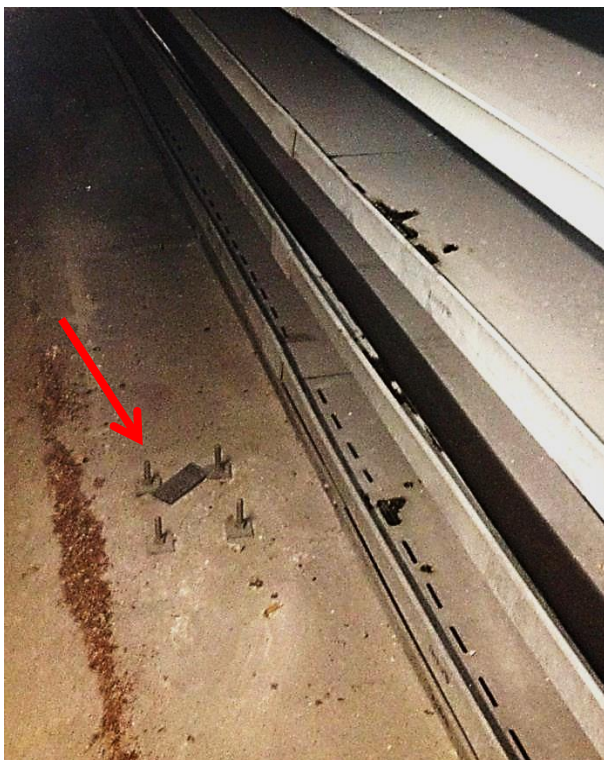
Abbildung 15: Herausstehende Gewindestangen im Bereich des Kollektorbodens
