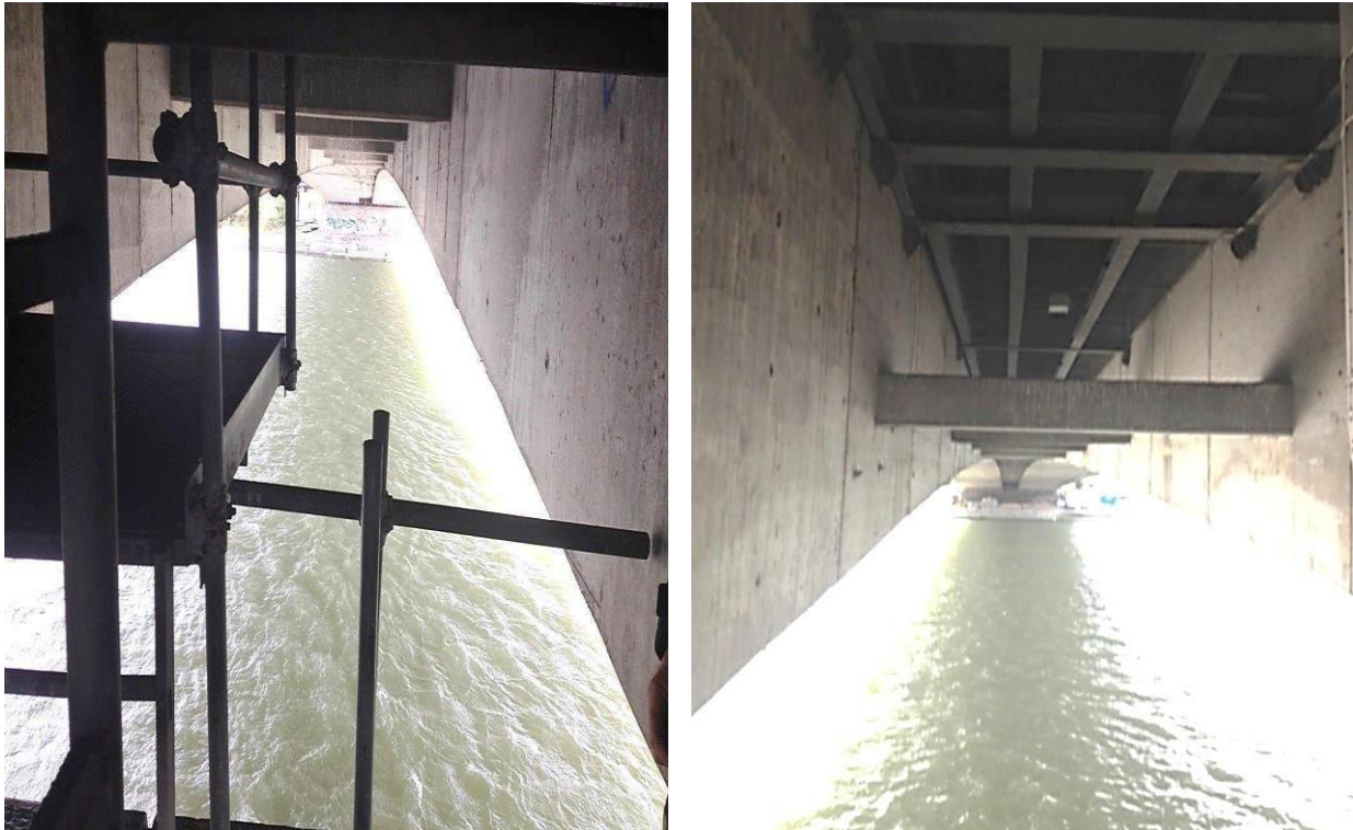
Abbildungen 9 und 10: Spannbetontragwerk über der Donau
